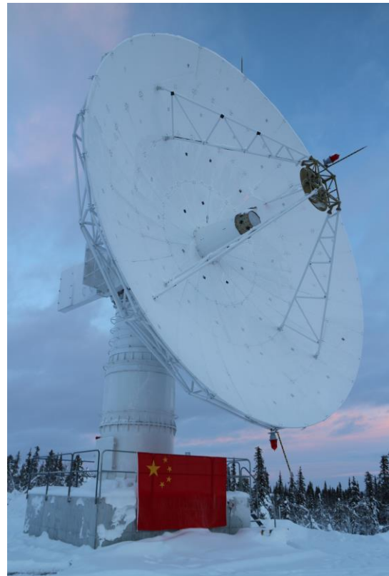
北极接收站建设完成的S/X/Ka三频段接收天线
